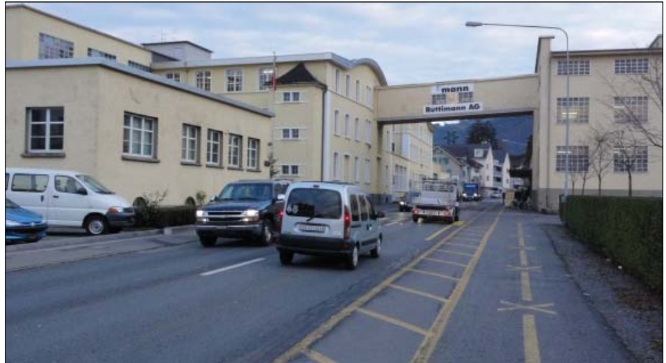
Foto: Fehlendes Trottoir entlang der Hauptstrasse in Galgenen
