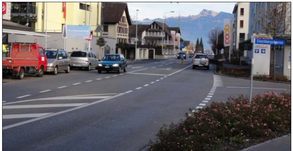
Foto: Fehlende Radstreifen entlang der Hauptstrasse
